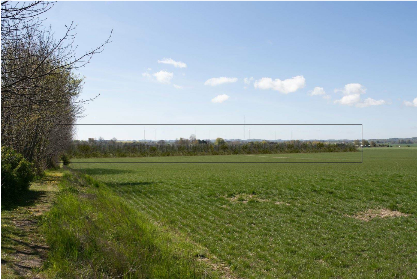
Foto 6 – Efter 5-10 år Den nye højspændingsstation Torslunde ses med omgivende beplantningsbælte. Master er fjernet og luftledninger er kabellagt.
